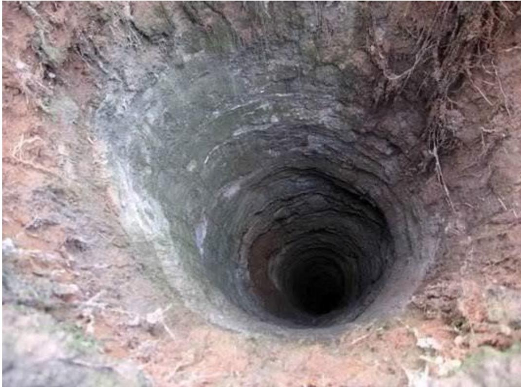
**Скважина** — это направленная цилиндрическая горная выработка в земле, диаметр «D» которой мал по сравнению с её длиной по стволу «H», сооруженная без доступа человека на забой.
